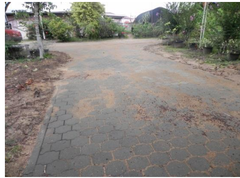
Fase 3 , een voorbeeld van de bestrating van het terrein. Er zijn veel onverharde wegen en weggedeelten bestraat. Dit ten behoeve van de medewerkers met een beperking, maar ook voor de klanten en bezoekers is dit belangrijk.
