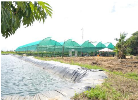
Fase 1 , de nieuwe kas met de wateropslag
