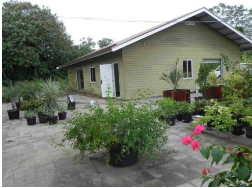
Fase 2 , het voorgebouw, met verschillende binnenruimtes en aangepaste toiletten
